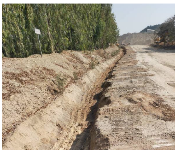
รูปที่ 2-6 คันทำนบดิน ร่องระบายน้ำบริเวณจุดเก็บกองเปลือกดิน และเศษหินชั่วคราว
