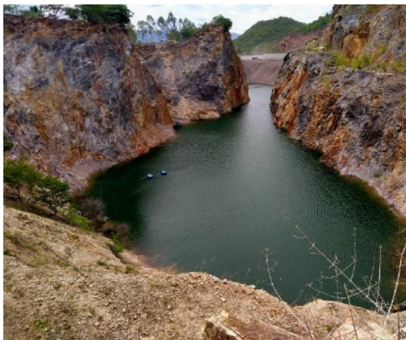
รูปที่ 2-10 จุดที่เป็นพื้นที่ต่ำที่ใช้เป็นพื้นที่รองรับปริมาณน้ำไหลบ่าจากพื้นที่หน้าเหมือง
