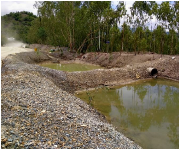
รูปที่ 2-8 บ่อดักตะกอนเพื่อรองรับรับชะล้างตามแนวเขตในพื้นที่เว้นการทำเหมืองในระยะ 10 เมตรรอบพื้นที่ประทานบัตรตามที่แผนผังโครงการกำหนด
